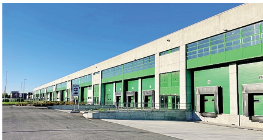
Il capannone della Prologis vicino all'aeroporto di Milano Linate, questa operazione rappresenta l'ultimo atto del piano di lottizzazione di Industrial Park interamente promosso e sviluppato da SIC - Sviluppo Immobiliare Corio a Peschiera Borromeo
